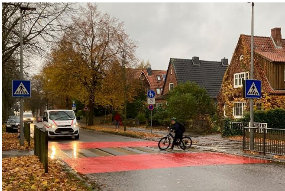
Rotmarkierung am Zebrastreifen an einer Gemeindestraße in Preetz
