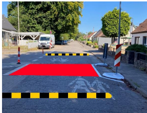
Rotmarkierung eines Querungsbereichs, Temposchwellen (Bildmontage)
